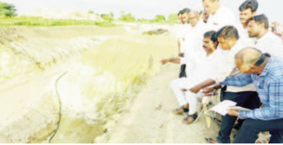
పంపుహౌస్ పనులను పరిశీలిస్తున్న ఎమ్మెల్యే మర్రి జనార్ధన్ రెడ్డి
