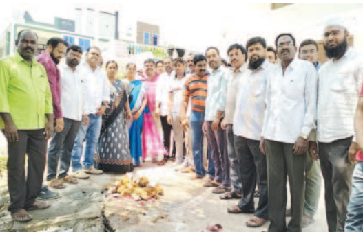
సీసీ రోడ్డు పనులను
